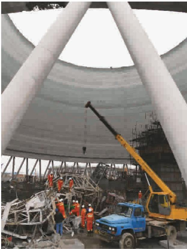
冷却塔与烟囱施工项目的工程部工程师廖辉寿介绍说,冷却塔属于复杂的建筑种类。冷却塔外壁薄,施工平台跟随施工进度抬升。发生事故时,丰城电厂三期的冷却塔已建设到70多米。
