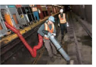
后,操作员将巨大的吸管从吸尘车拽到铁轨,吸走所有的垃圾。MTA的目标是在2017年底和2018年推出3列新型吸尘列车,辅以27节拖新型“垃圾车厢”。它们走客车同样的路线,只是不载客而每天收集数十立方米的垃圾。
