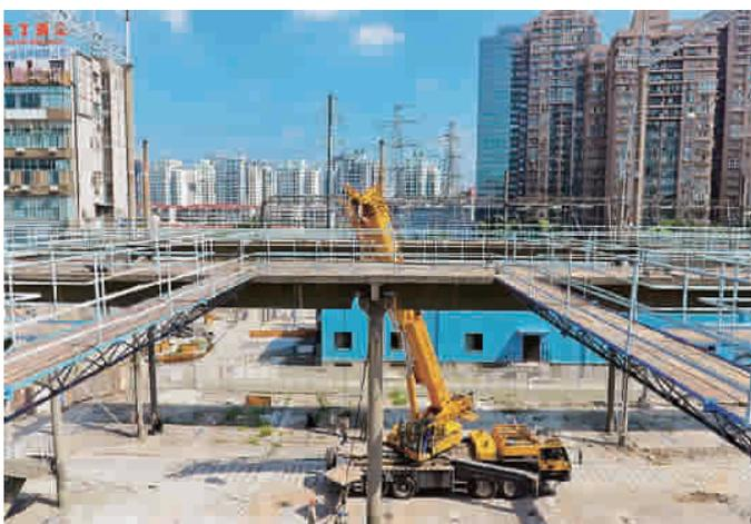
■ 上海电网最后一座高层构架——220 千伏长春站构架拆除 梁嘉晟 摄
