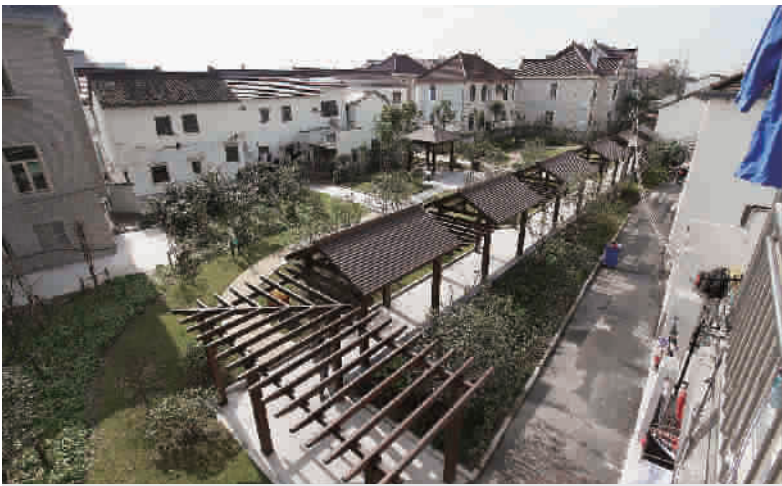
■ 村庄违建建房整治后,新建了漂亮的纳凉廊道
