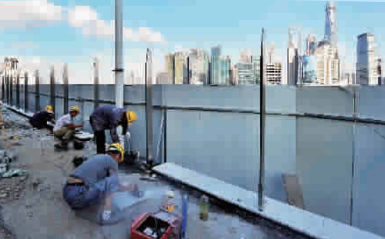
■ 今年5月，工人在虹口滨江段紧锣密鼓施工 杨建正 摄
