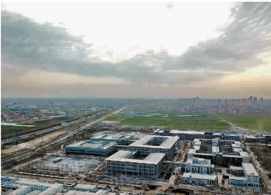
■ 雄安市民服务中心施工现场(无人机拍摄)
