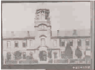
■ 中国公学大钟楼
