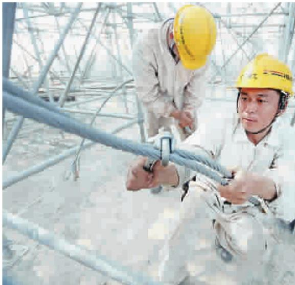
楼防 临港松江科技城:建筑工人正在加装晚间照明固定斜撑,箍紧防台缆风绳
