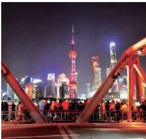
■ 璀璨的景观灯勾勒出外白渡桥刚毅的轮廓 杨建正 摄
