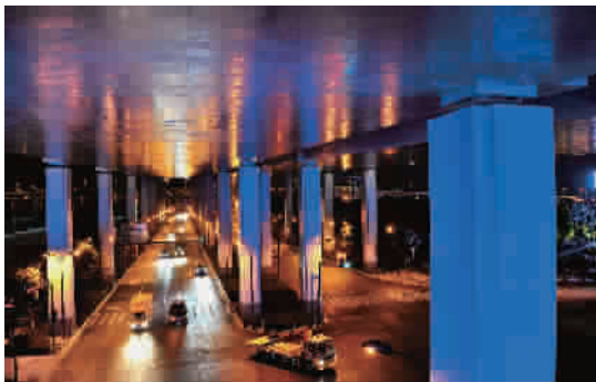
■ 嘉闵高架桥下，灯景绚烂
