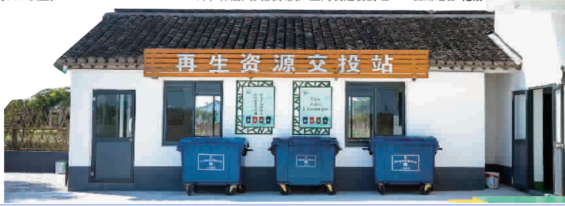
青浦重固镇徐姚村再生资源交投站
