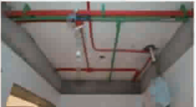
冷热水管分槽布管、水电布局横平竖直、管道标识明晰可见、成品保护到位……整个现场施工规范合理。
