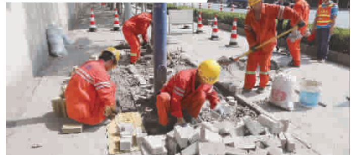
■ 施工人员在修盲道 本报记者 王凯 摄
