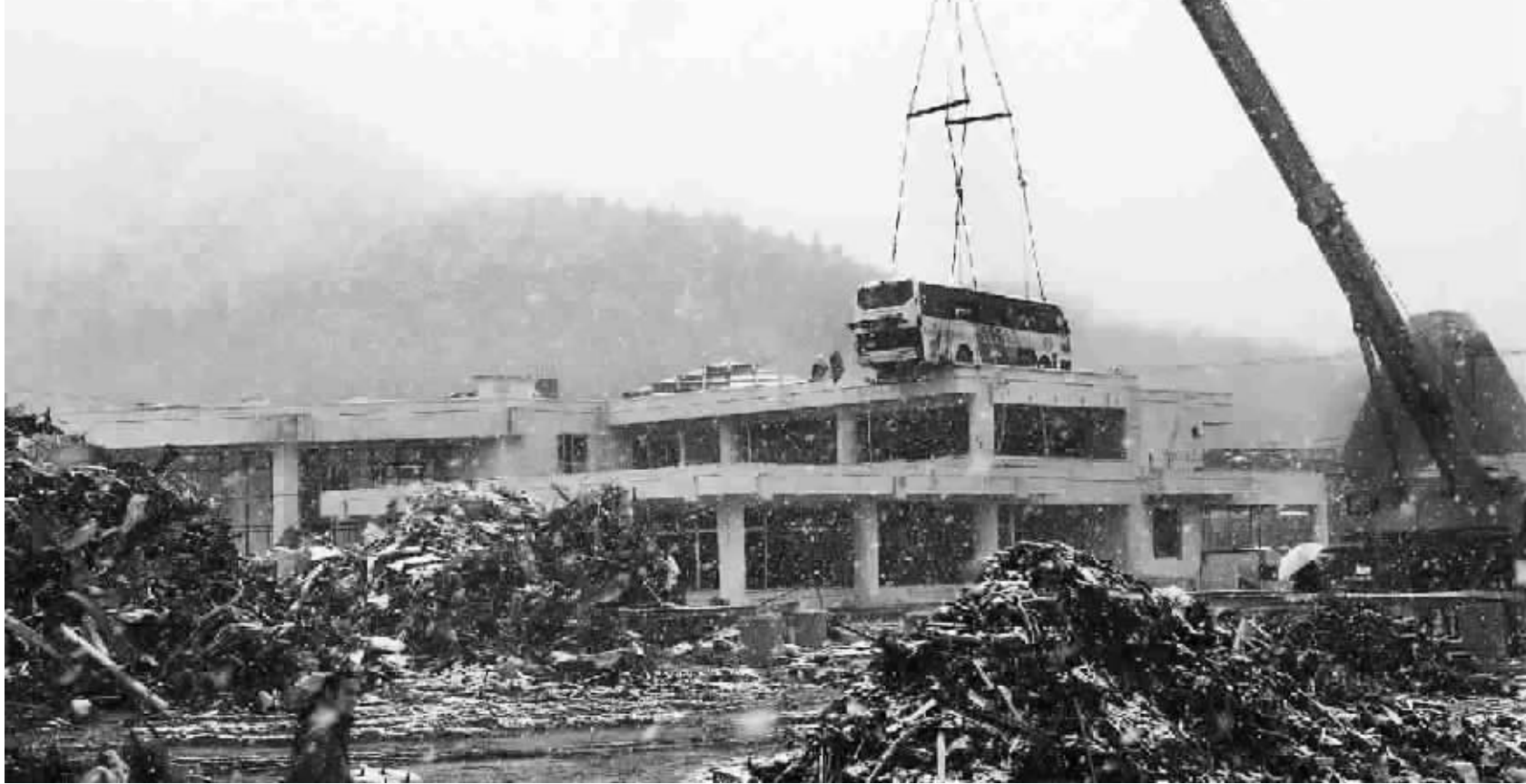
■ 昨天上午,在宫城县石卷市雄胜町公民会馆楼顶停了一年的大客车被吊离楼顶
