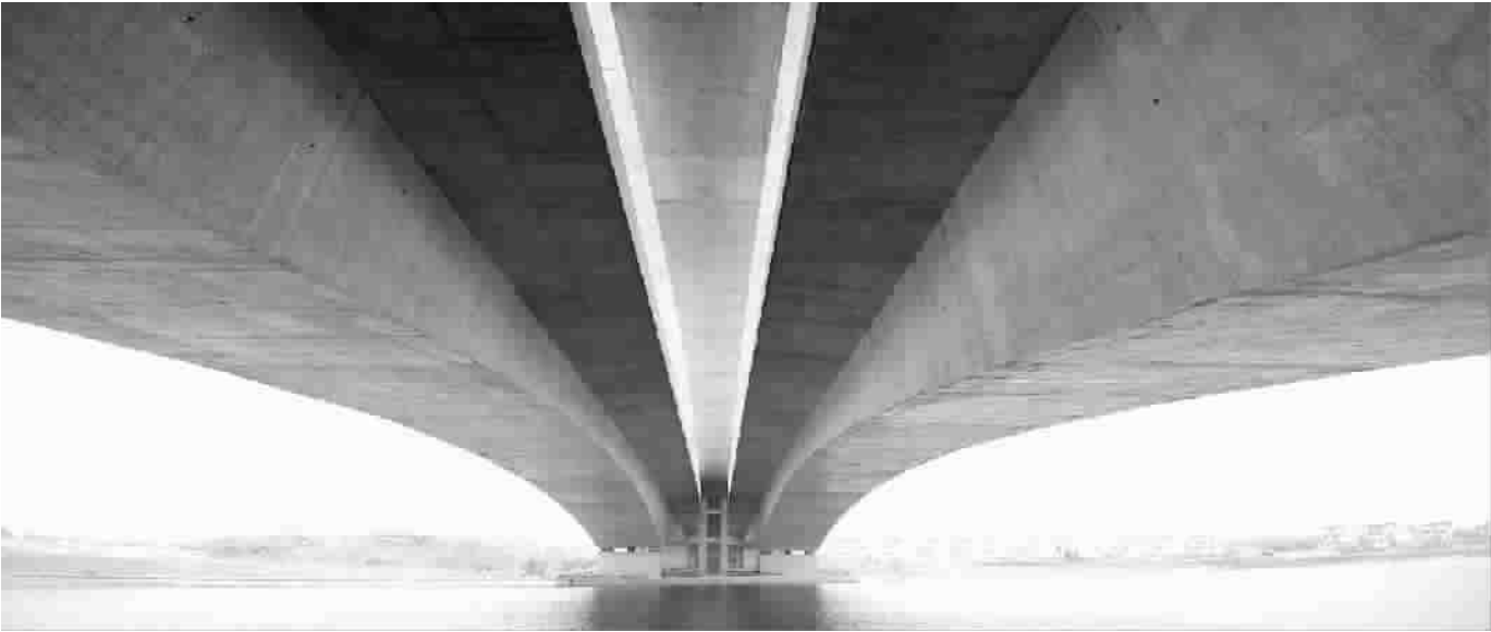
■上午合龙的泐马河大桥
