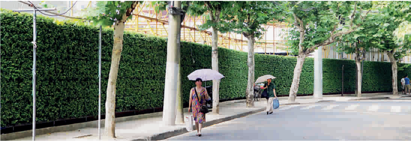
■ 绿墙围起崇德路上的一个工地,把尘埃与行人隔开
