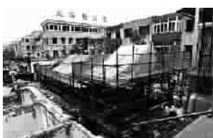
■ 梁林故居恢复工程现场
