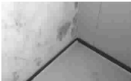
■ 墙壁渗水发霉,不得不拆开维修
