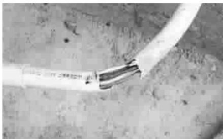
■ 铺设的塑胶管断裂电线裸露 朱正炎 摄
