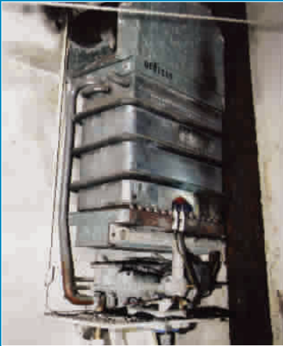
造成悲剧的热水器明显陈旧老化
