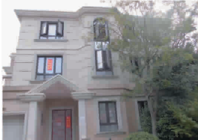
图为由波涛装饰担纲设计装修的泗泾顺景园别墅施工现场外景
