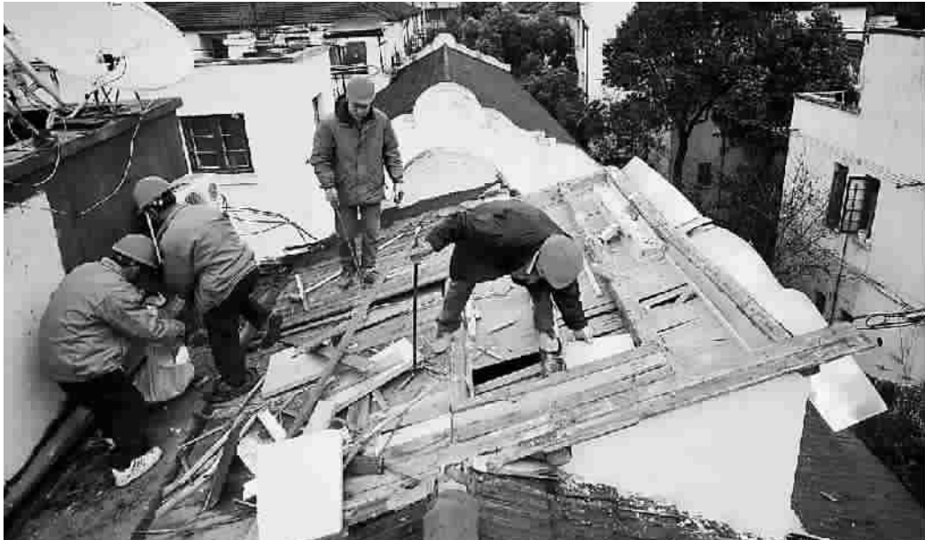
■ 执法人员拆除永嘉路580弄40号屋顶违法建筑
