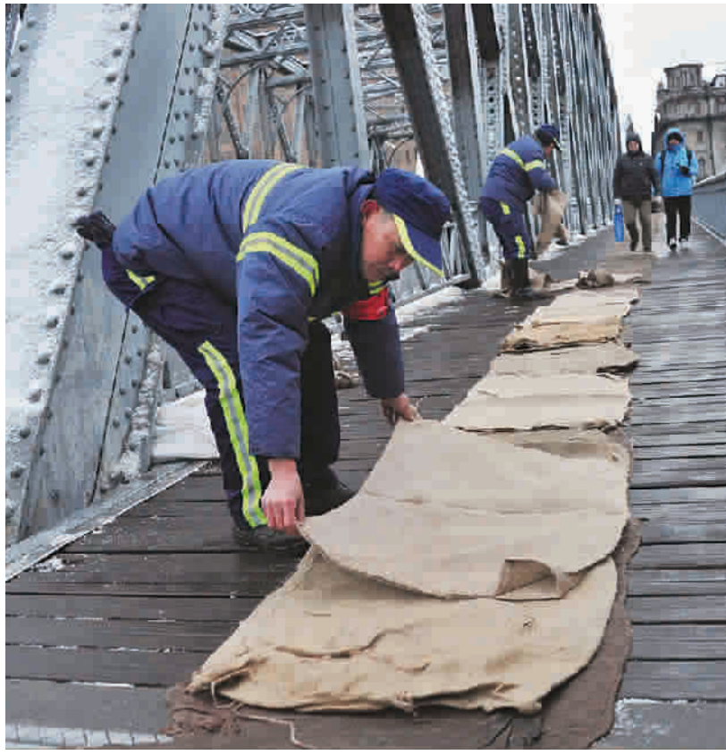
今晨，环卫保洁工人在外白渡桥结冰的路上铺设麻包，避免路人滑倒
