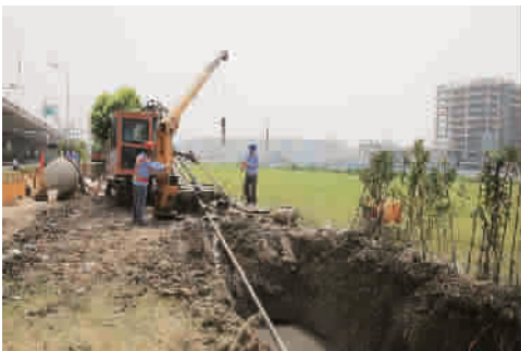
加快推进金泽水库送电工程
