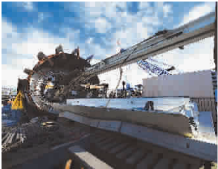
■ 地下隧道工程项目
