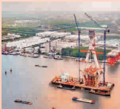
■ 建设中的闵浦三桥
