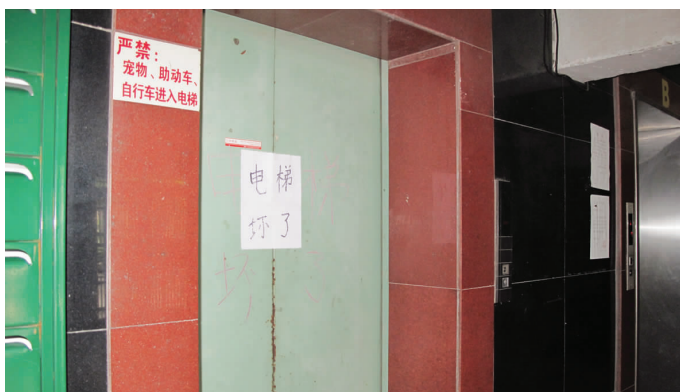
■ 密云小区200多户居民如今只能靠一部电梯上下楼
